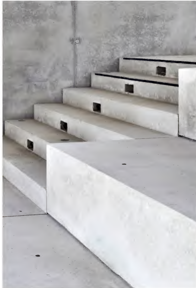
Sitzstufen - Betonfertigteil / hellgrau
