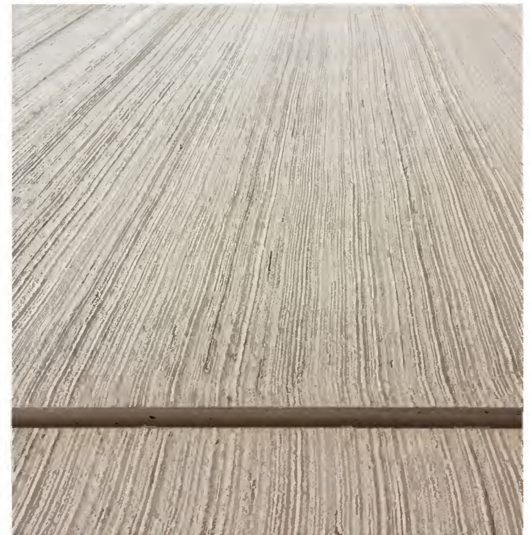
Kragplatte - Betonfertigteil, Besenstrich / hellgrau
