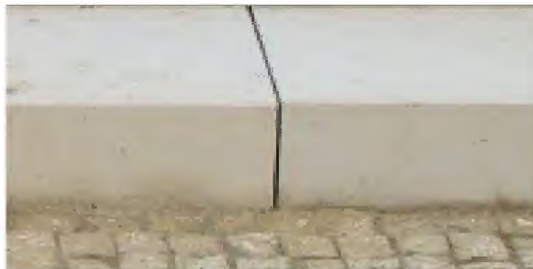
Einfassungsband - Betonfertigteil / hellgrau
