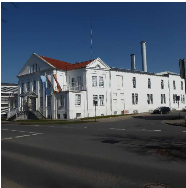
Abbildung 17: Stadtwerke: Ausgangspunkt der Fernwärme in Lemgo
